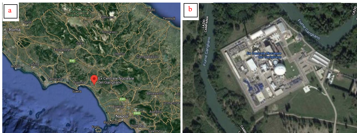
Figura 5– a) Individuazione geografica del sito di Garigliano; b) Vista aerea dell’installazione.
