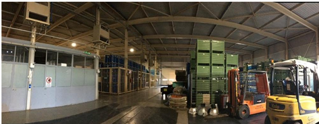
Figura 3 - Edificio BLD3 - Vista panoramica interna
